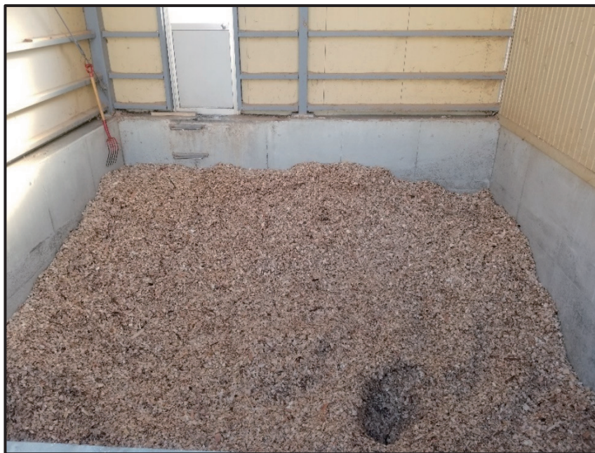
写真 2.5 梅里苑における木質チップの倉庫
